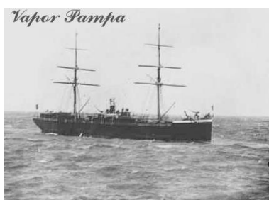
Vapor Ester/ Pampa
